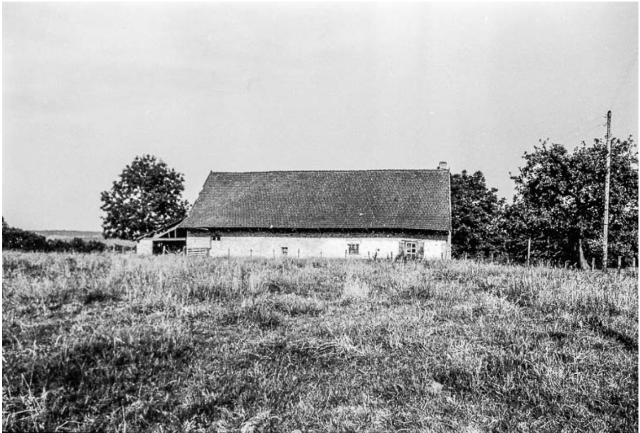
Ferme cadastrée 1969 AD 192 : vue d'ensemble.
