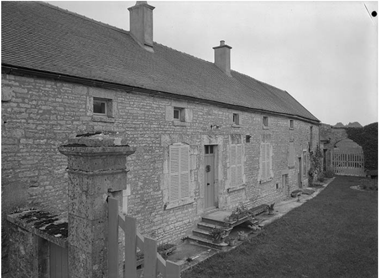
Maison et dépendances. Façades sur cour.
