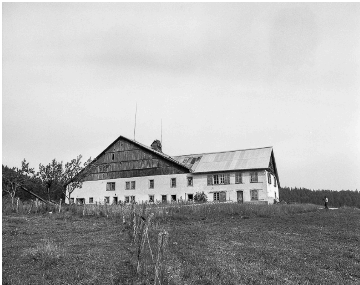
Ferme située au lieu-dit Les Charmottes, cadastrée 1966 F4 167 : façade antérieure.
