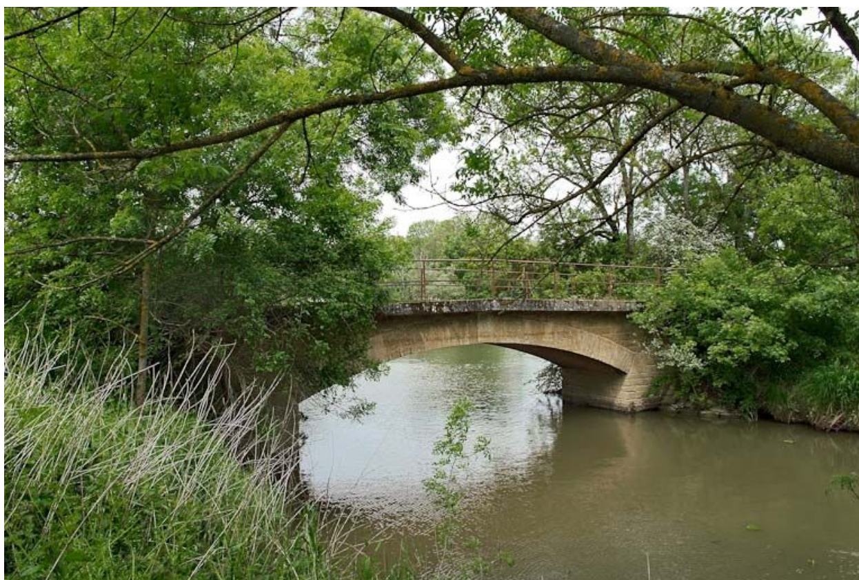
Vue d'ensemble du pont.
