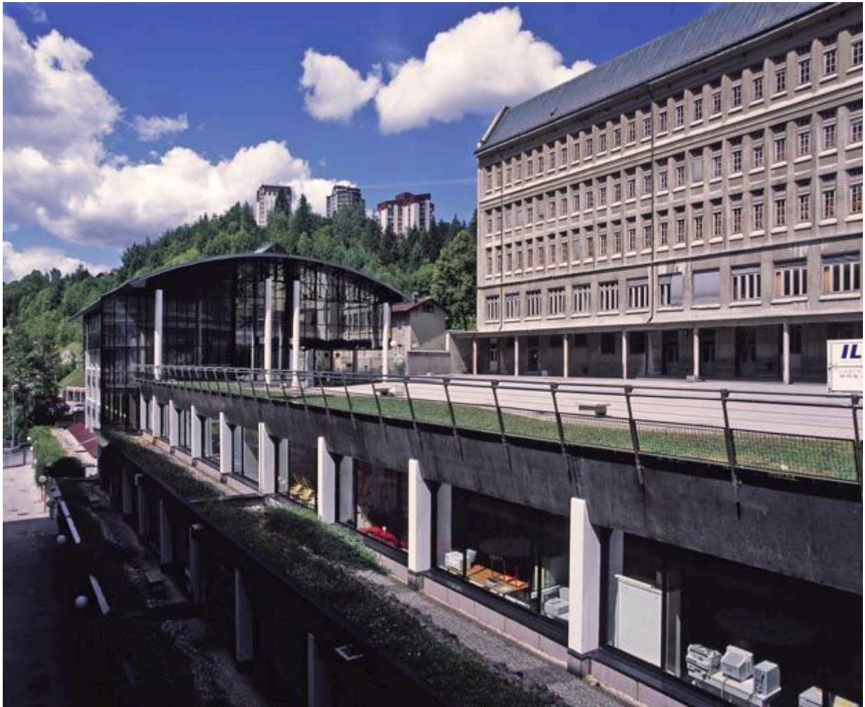
Bâtiments E et F : façade occidentale (avant restauration du bâtiment D).
