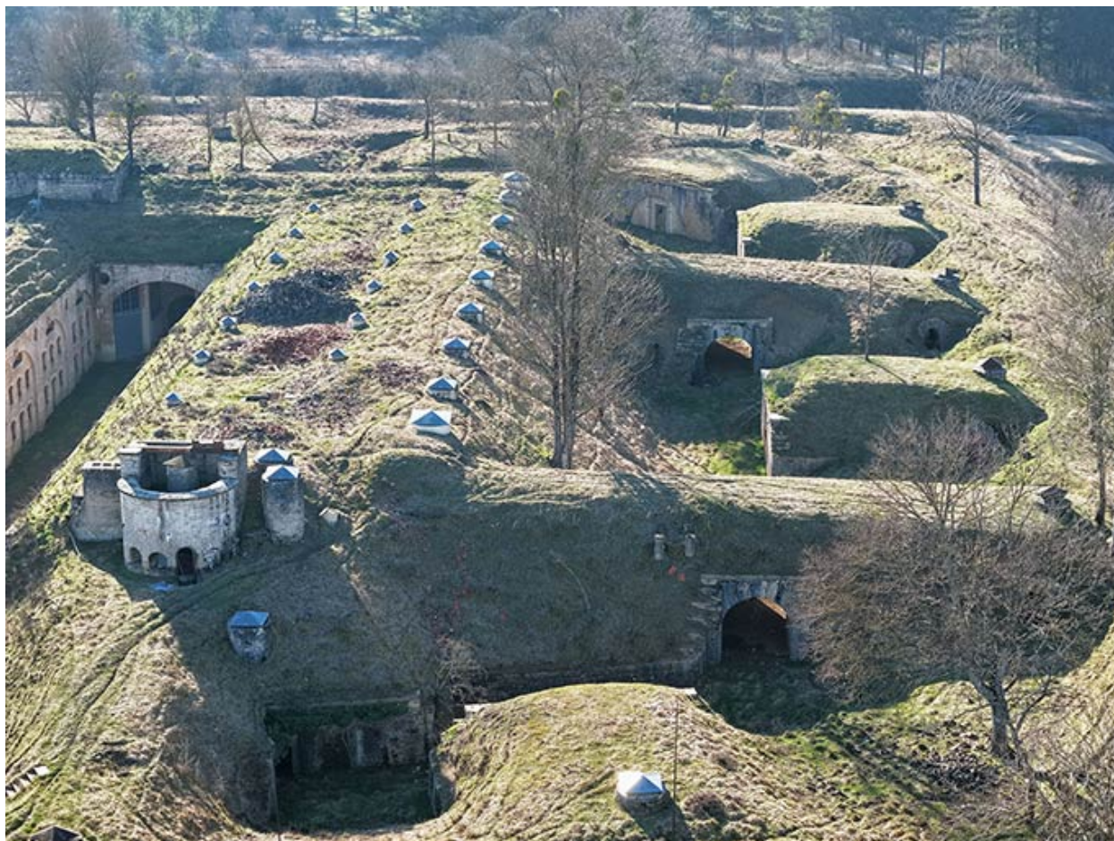
Les plateformes de tir et les traverses-abris (façade nord). (vue aérienne).
