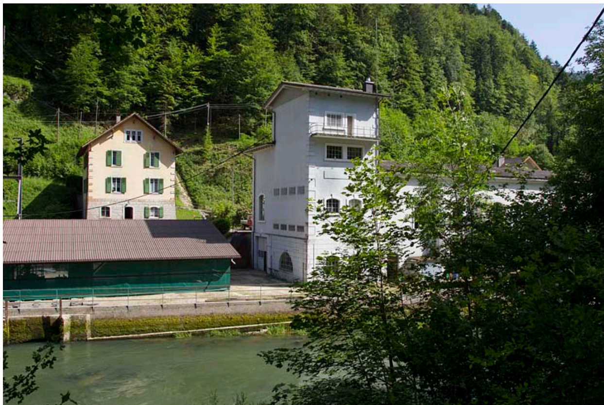
Centrale de la Goule : logement et centrale.
