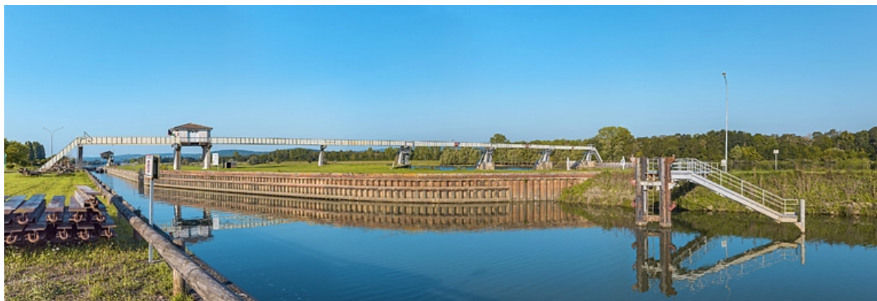
L'écluse vue d'amont.
