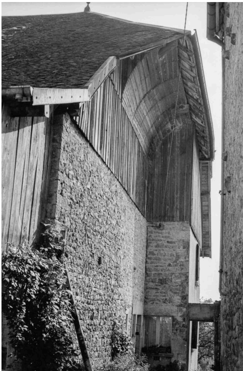
Ferme cadastrée 1961 AB 50 : façade postérieure (?).
