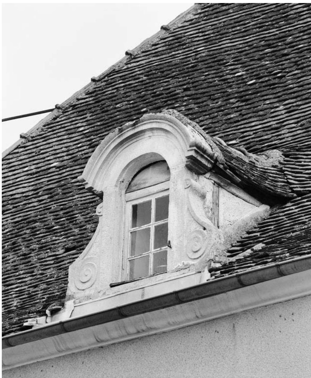
Détail d'une lucarne.
