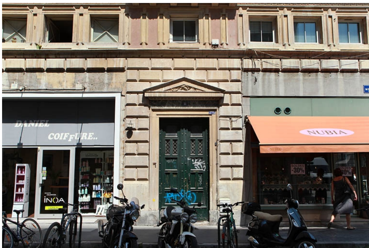
Façade antérieure : détail du rez-de-chaussée, de face.
