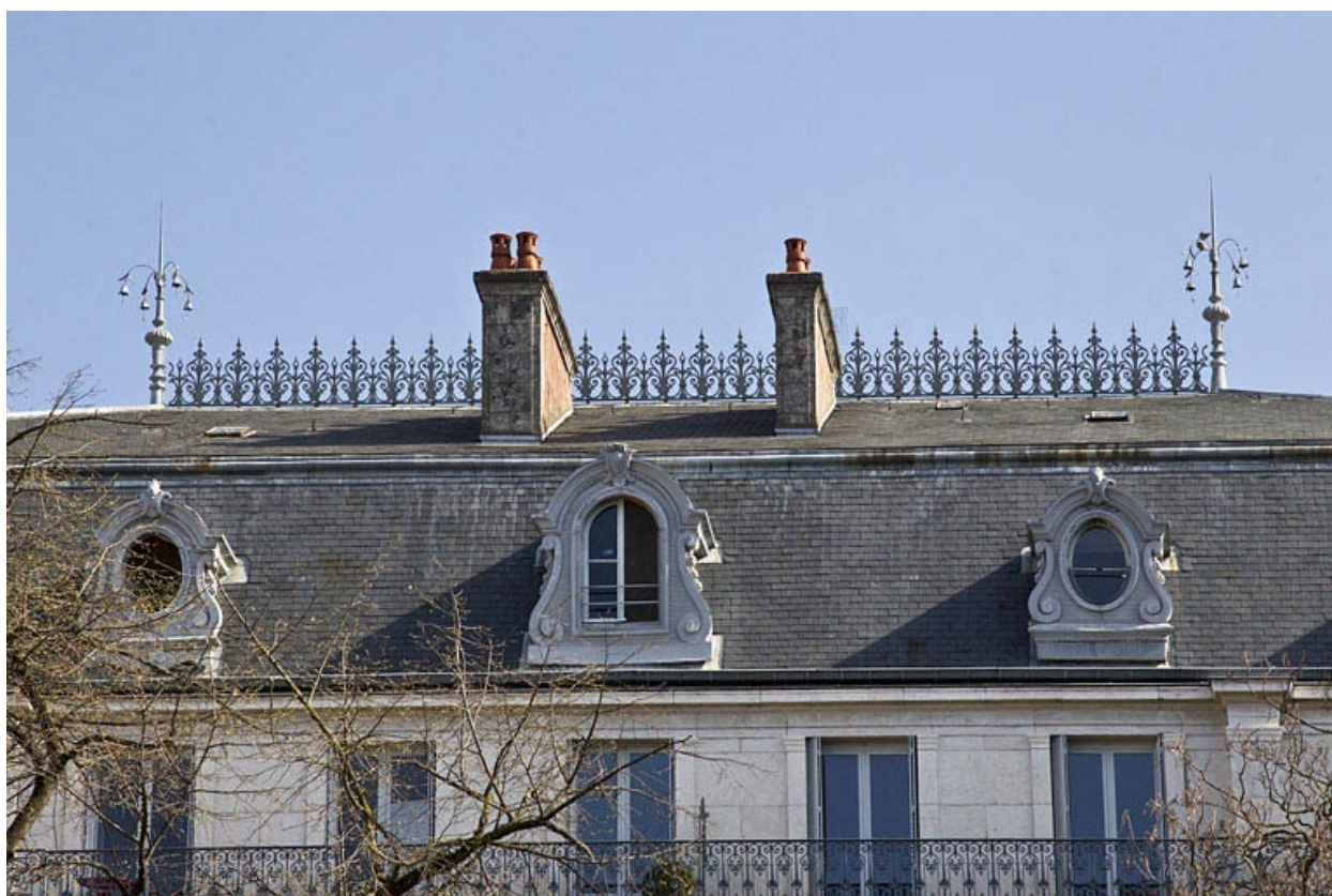
Détail de la toiture en ardoise.
