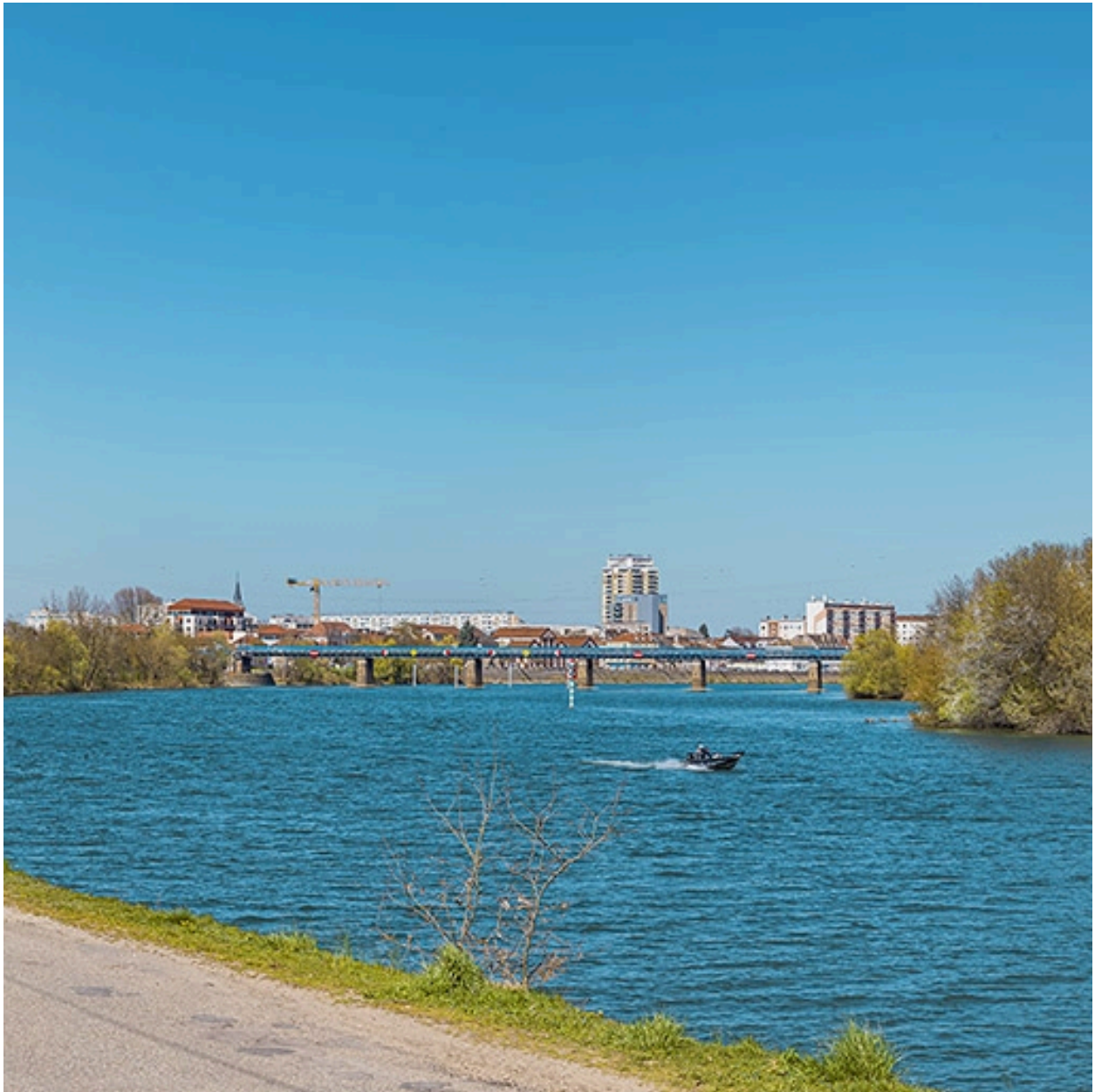
Vue d'ensemble du pont, depuis l'aval.
