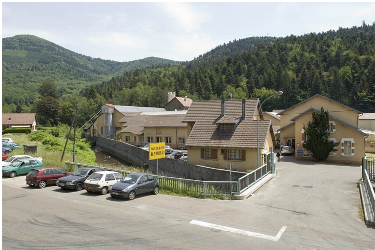
Partie nord de l'usine depuis l'entrée.
