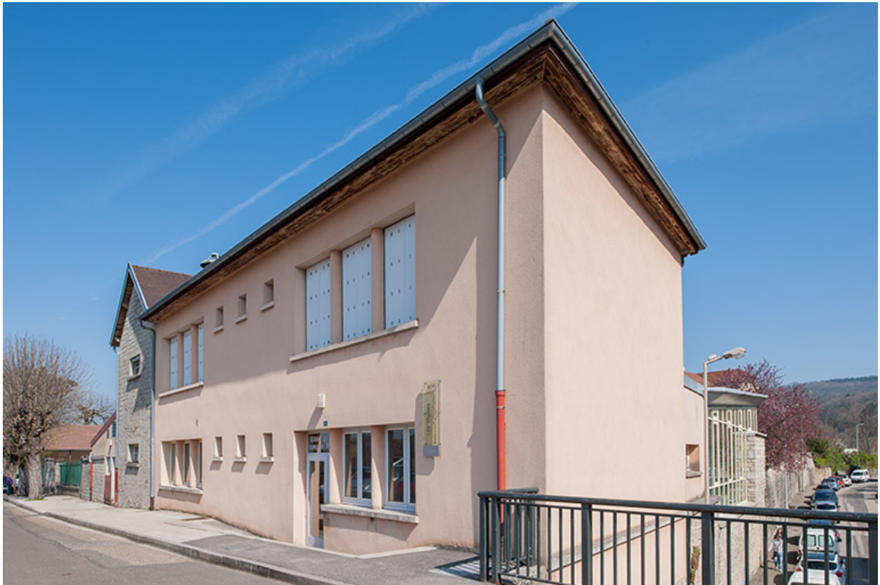
Annexe : façade antérieure, rue des écoles.
