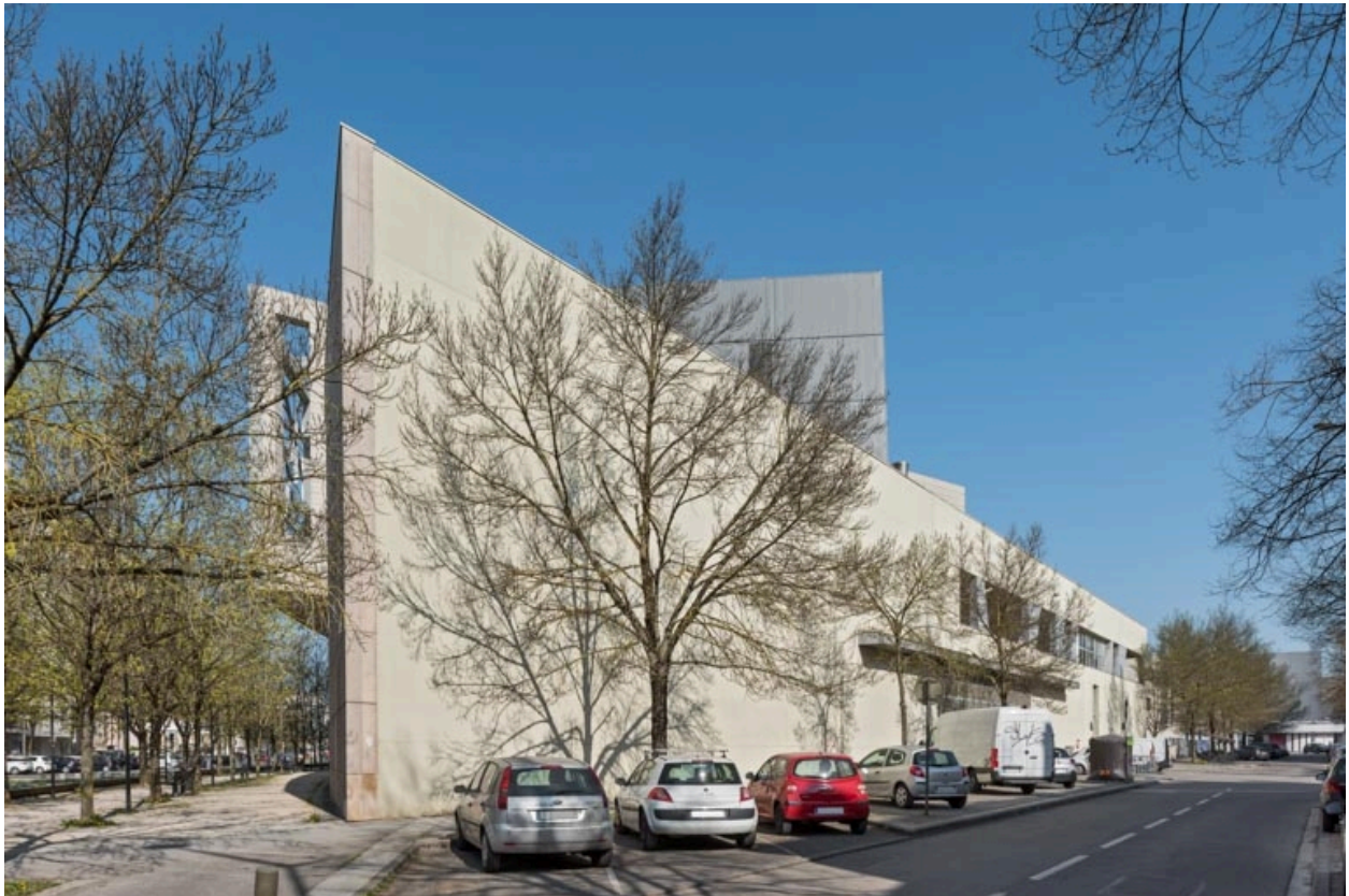
Façade sur le boulevard de Verdun (est), vue de trois quarts gauche.
