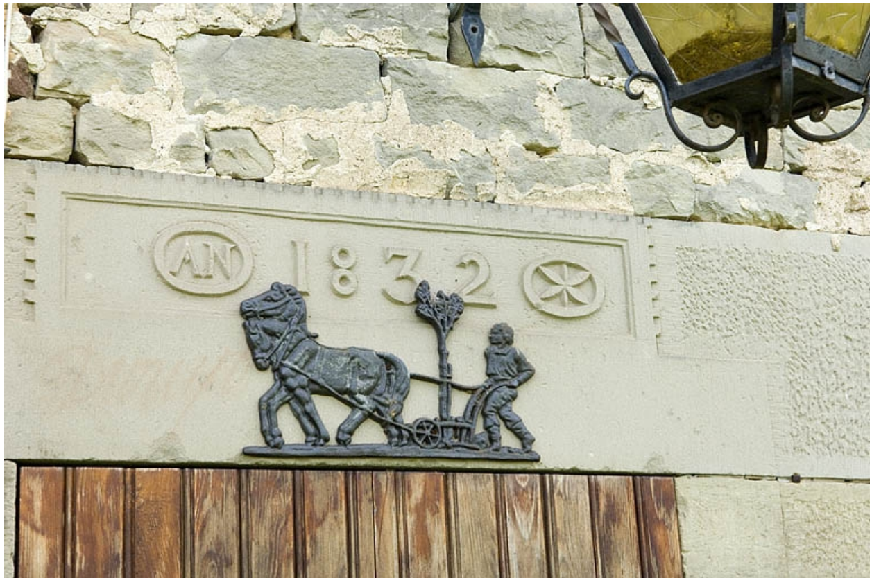
Logement ouvrier collectif (est). Détail d'un linteau.
