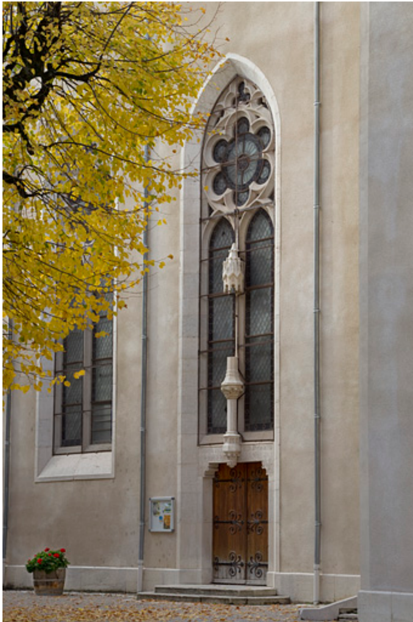
Baie et porte d'une travée de la façade sud de la chapelle.
