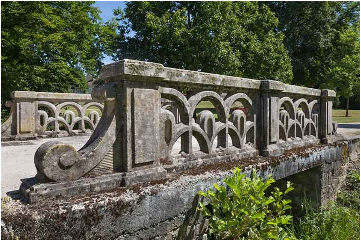
Pont à garde-corps en pierre.
