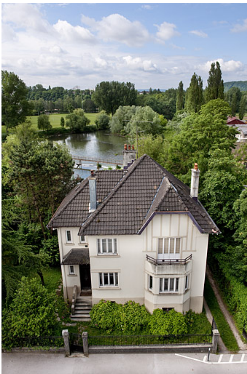
Vue plongeante sur le logement patronal.
