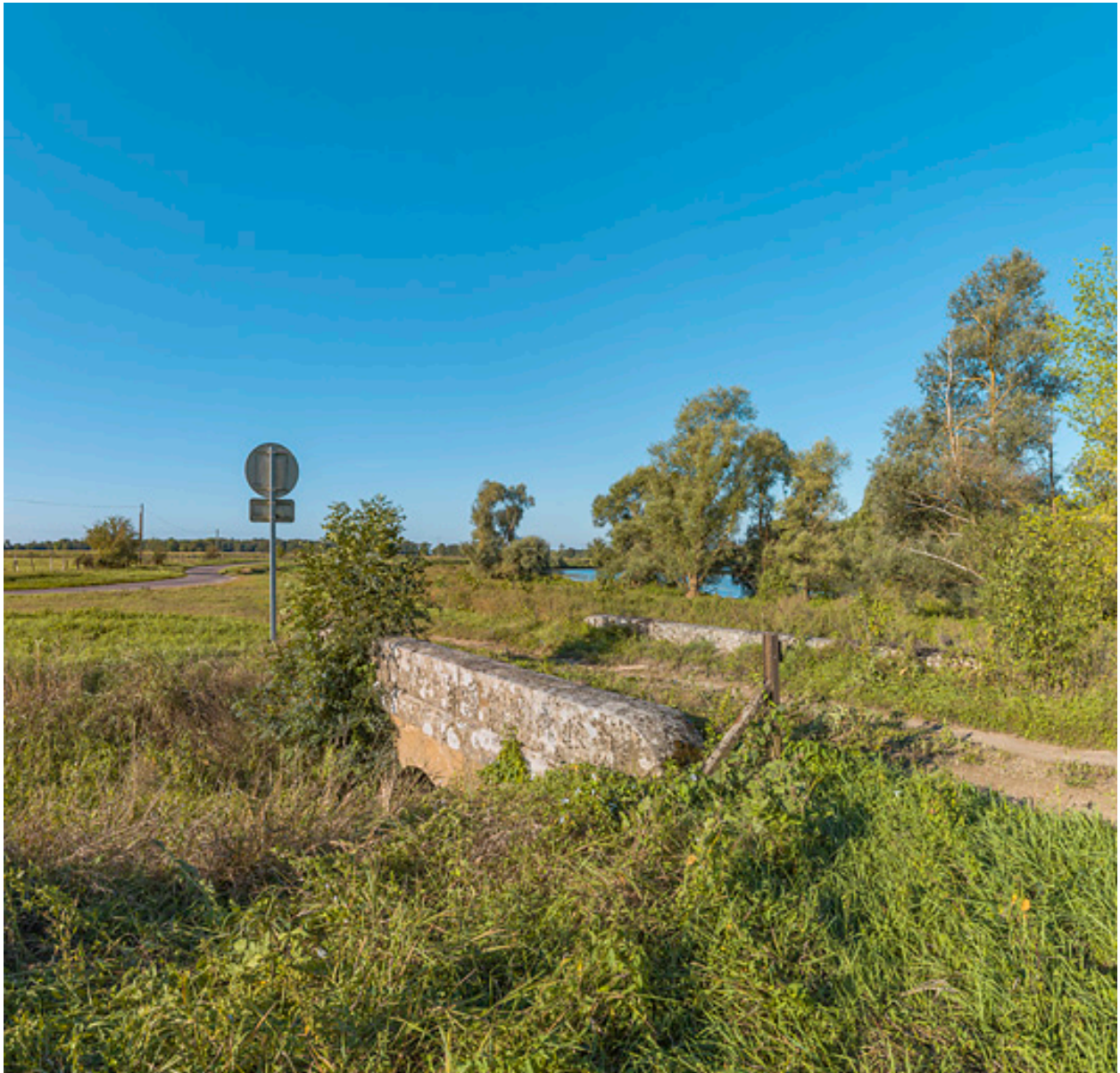
Chemin de halage et ponceau, le long du bief de Charnay sur le chemin de l'ancienne écluse.
