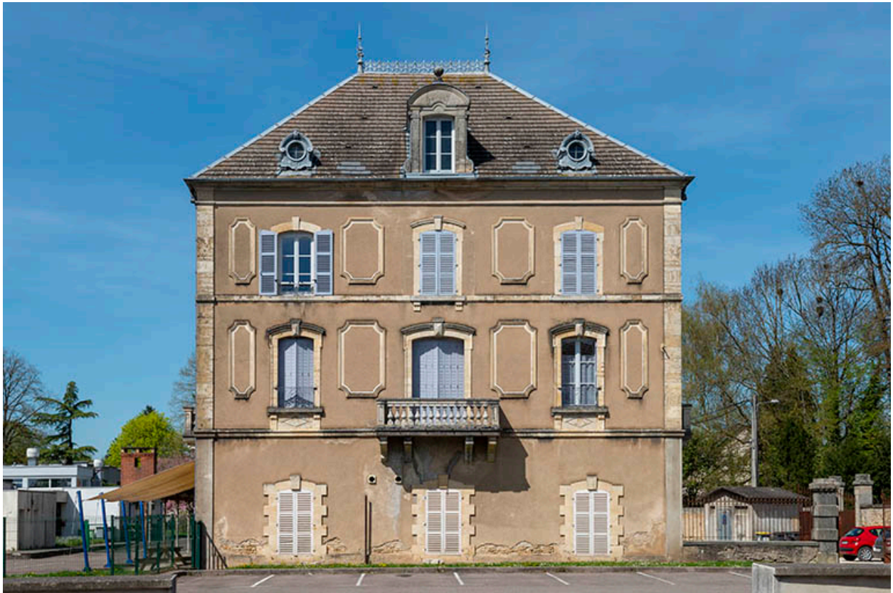
Corps de bâtiment sud, vue de face.
