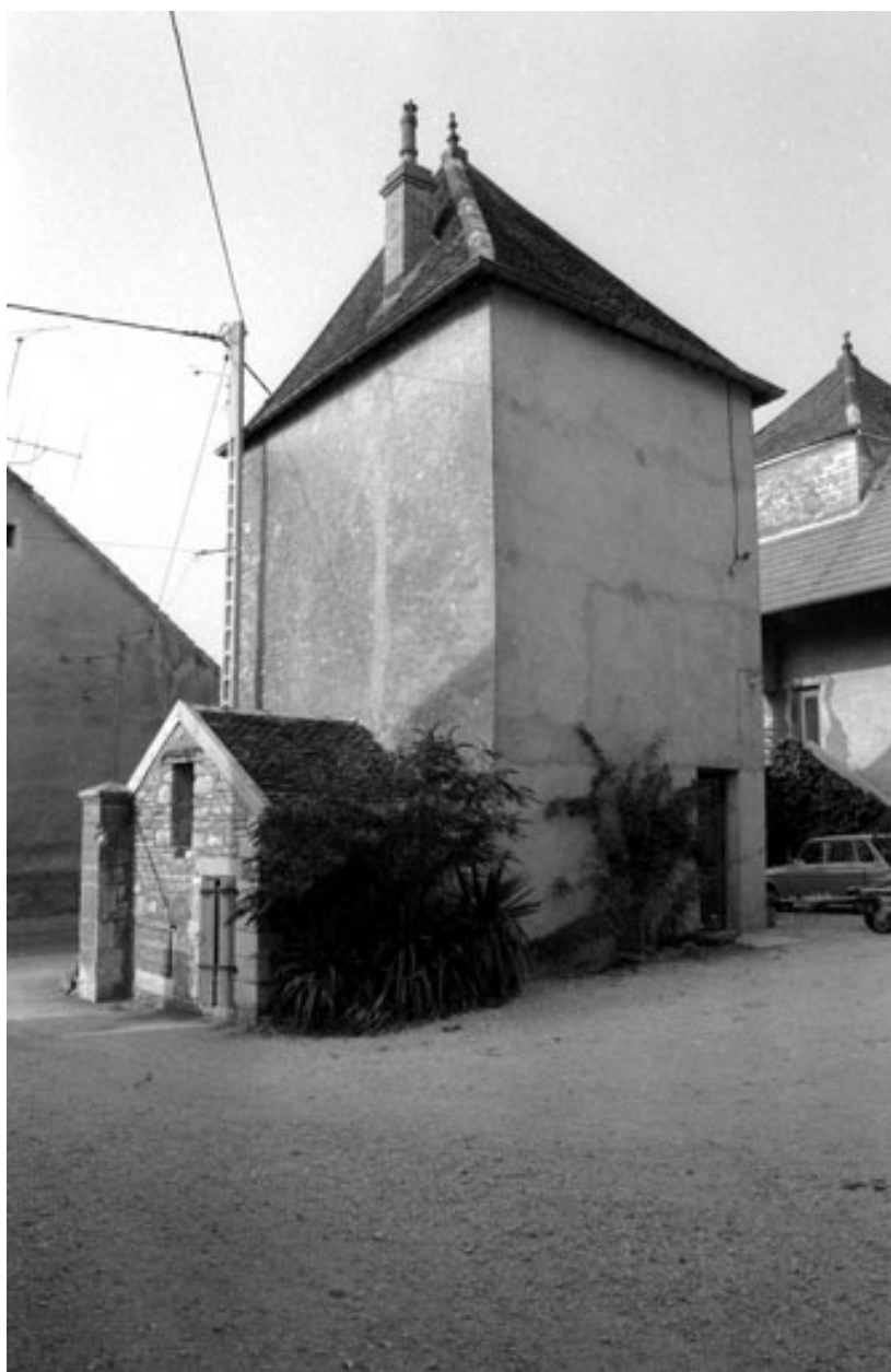
Tour vue depuis la cour.
