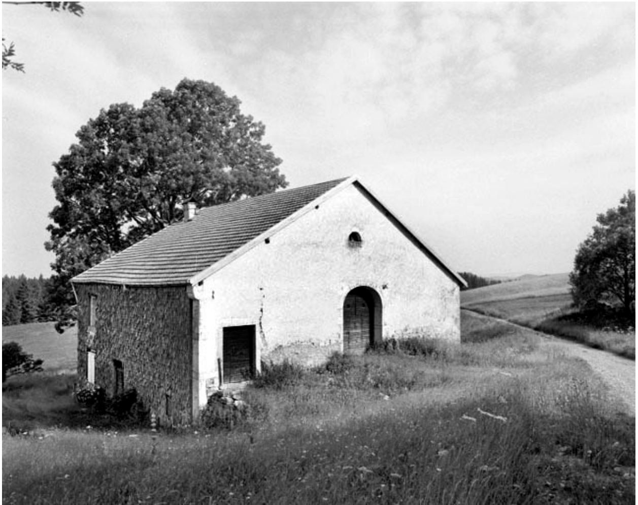
La Pesse, ferme située au lieu-dit Le Reculet : accès à la grange haute par le terrain naturel.
