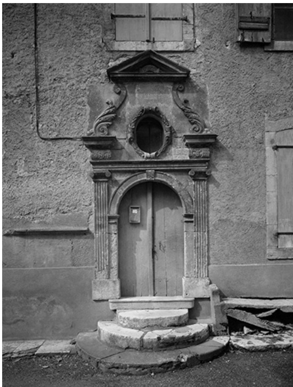
Détail du portail d'entrée.
