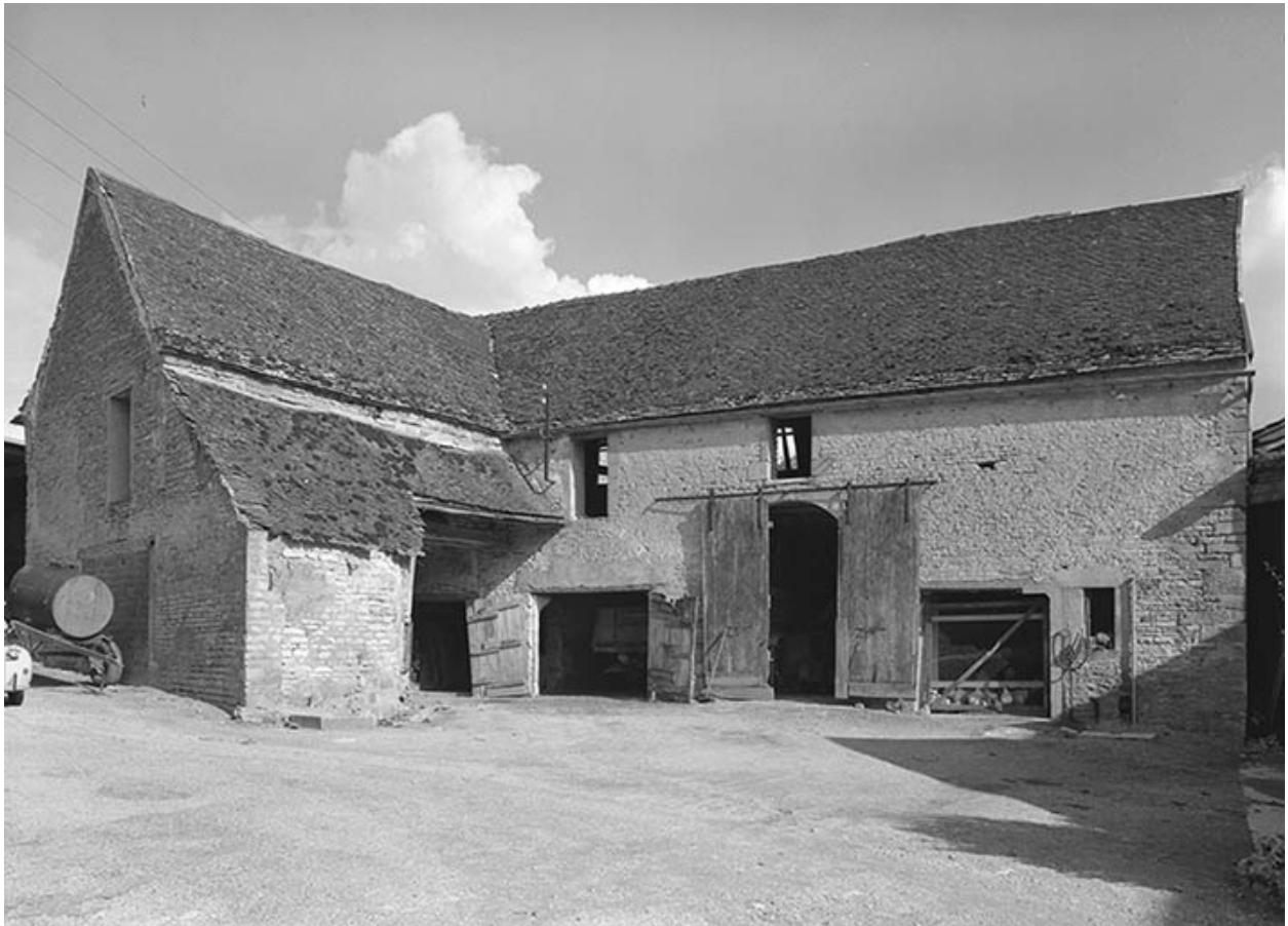
Bâtiments d'exploitation. Façades sur cour.
