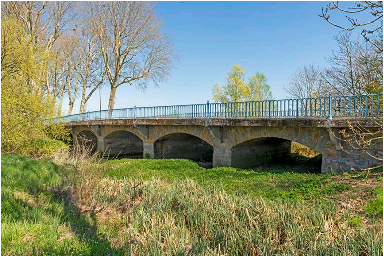
L'ensemble du pont, vu de l'ouest.
