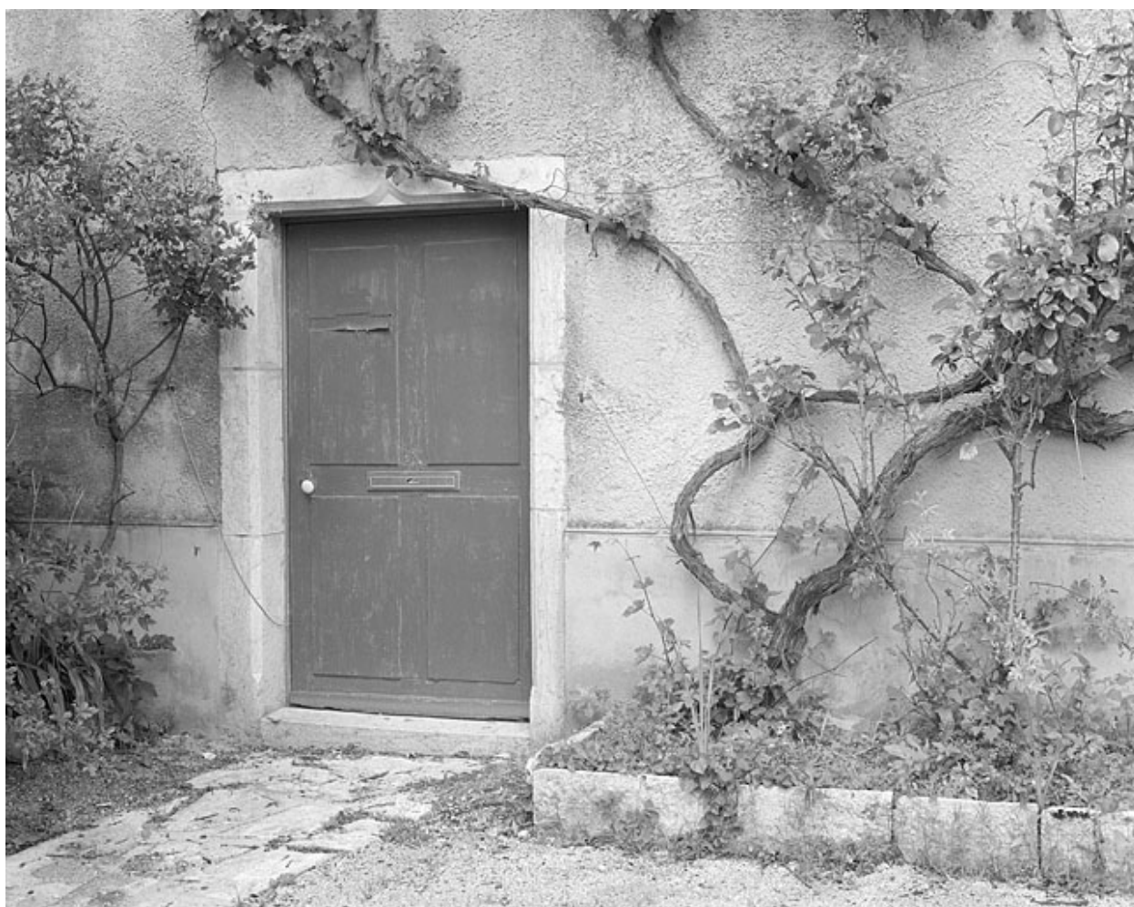
Façade antérieure, détail d'une porte.
