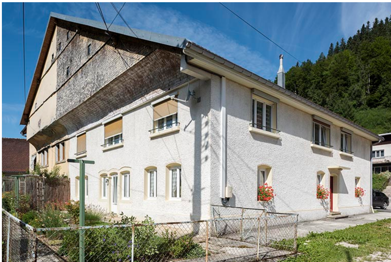
Façades postérieure et latérale gauche.
