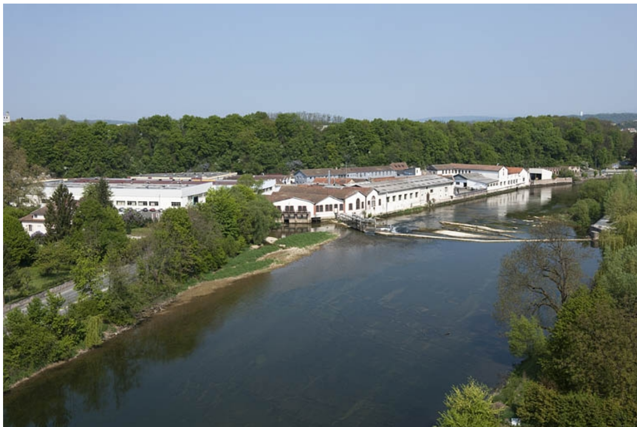
Vue plongeante depuis le sud-est.
