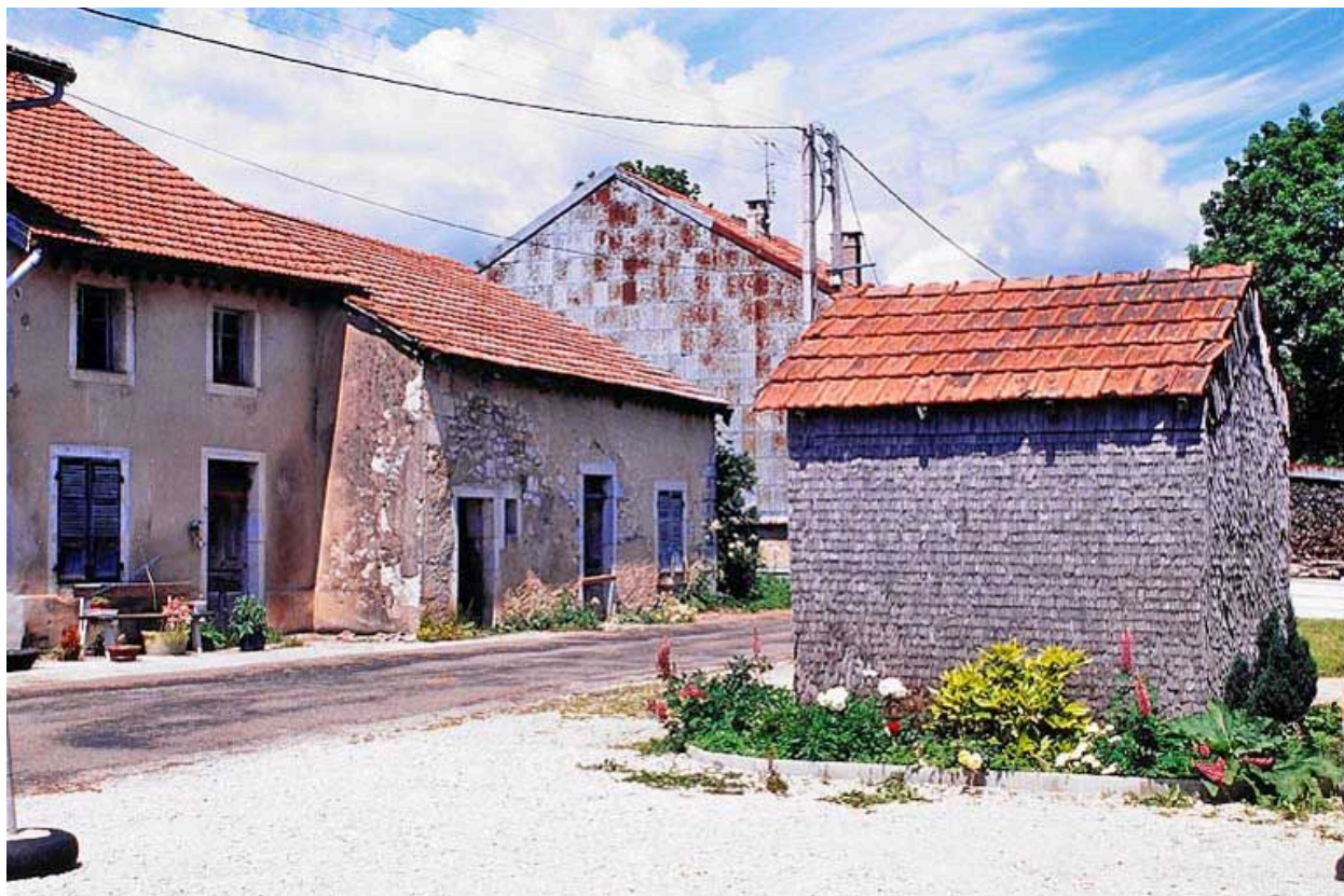
Ferme située au lieudit Orcières.
