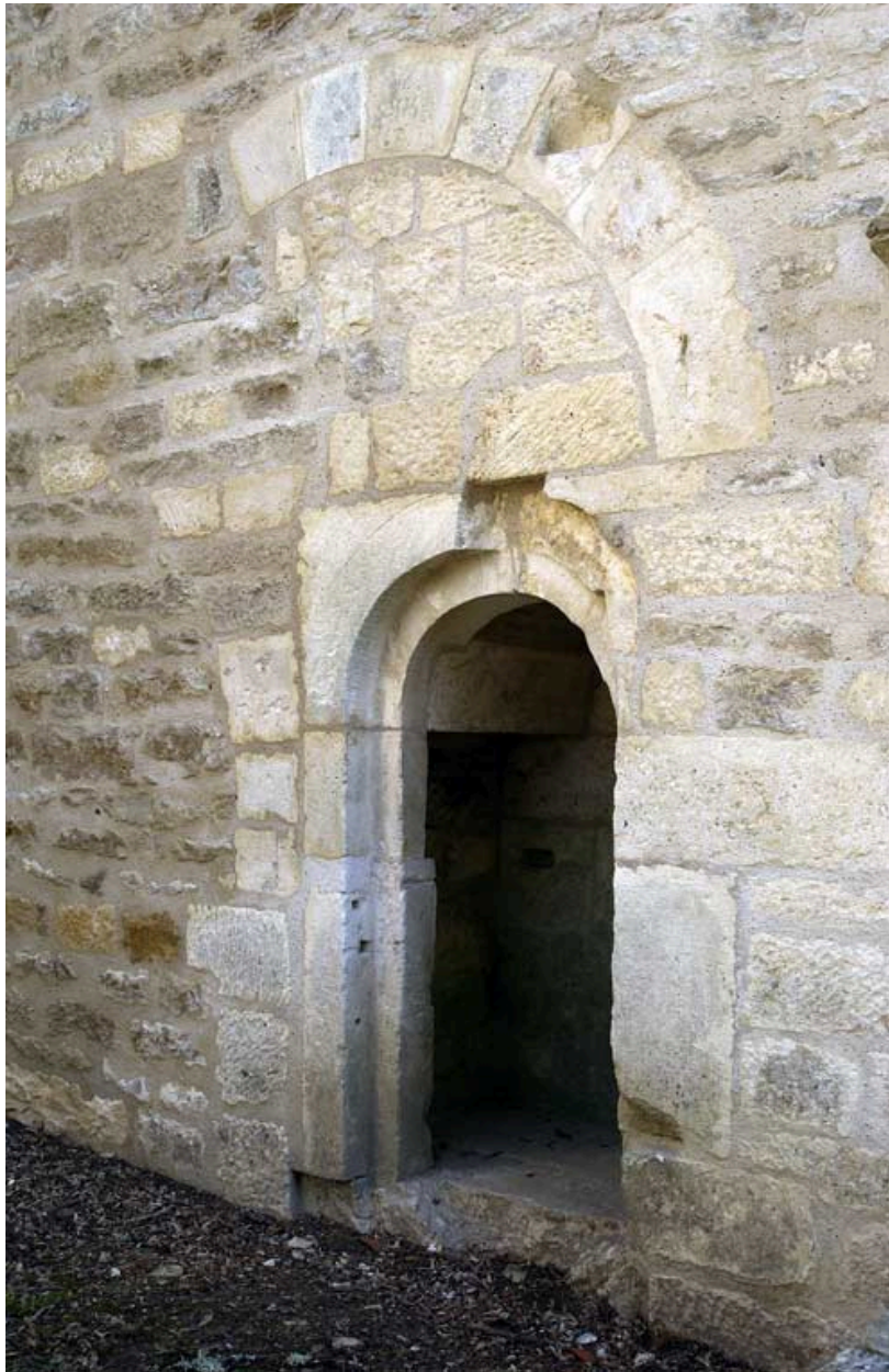
Extrémité nord de l'aile orientale : élévation ouest, porte de l'armarium (?).
