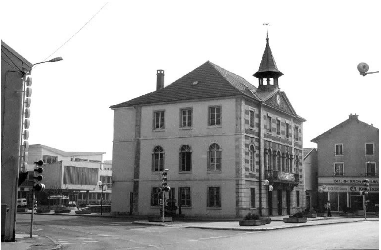
Façades antérieure et latérale droite.
