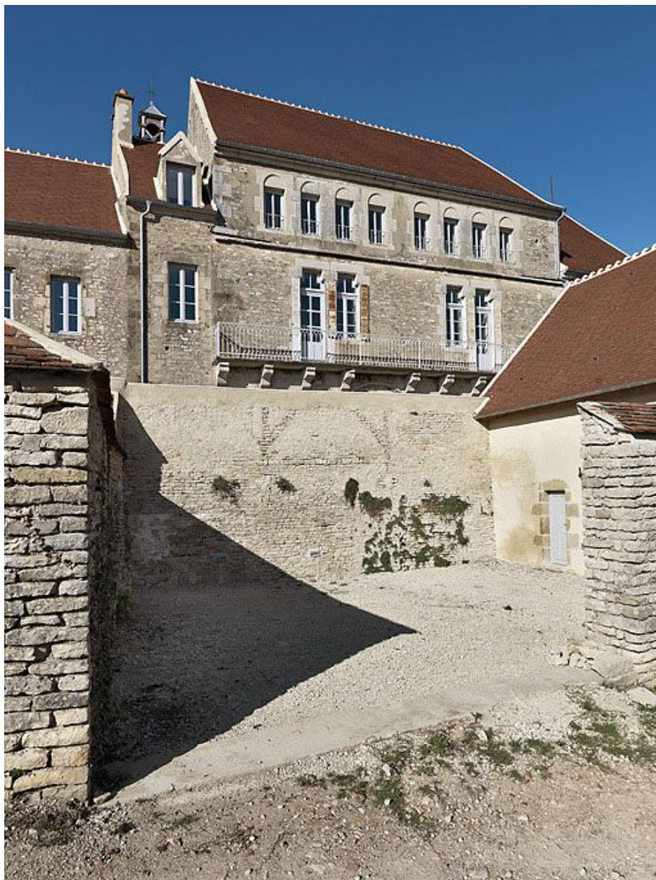
Façade postérieure du corps de bâtiment principal.
