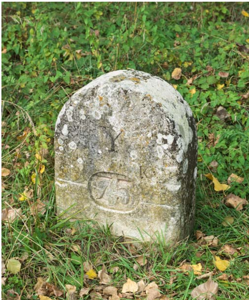
Vue d'ensemble de la borne.
