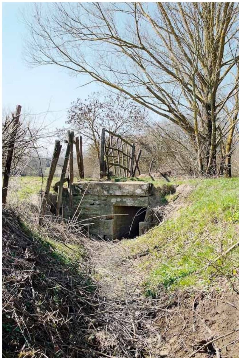
L'aqueduc, vue d'ensemble.
