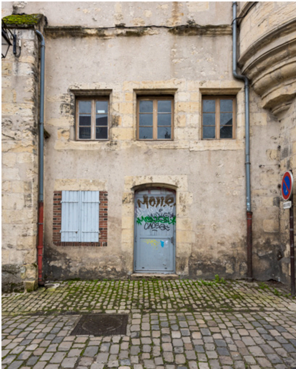
Façade postérieure : partie gauche.
