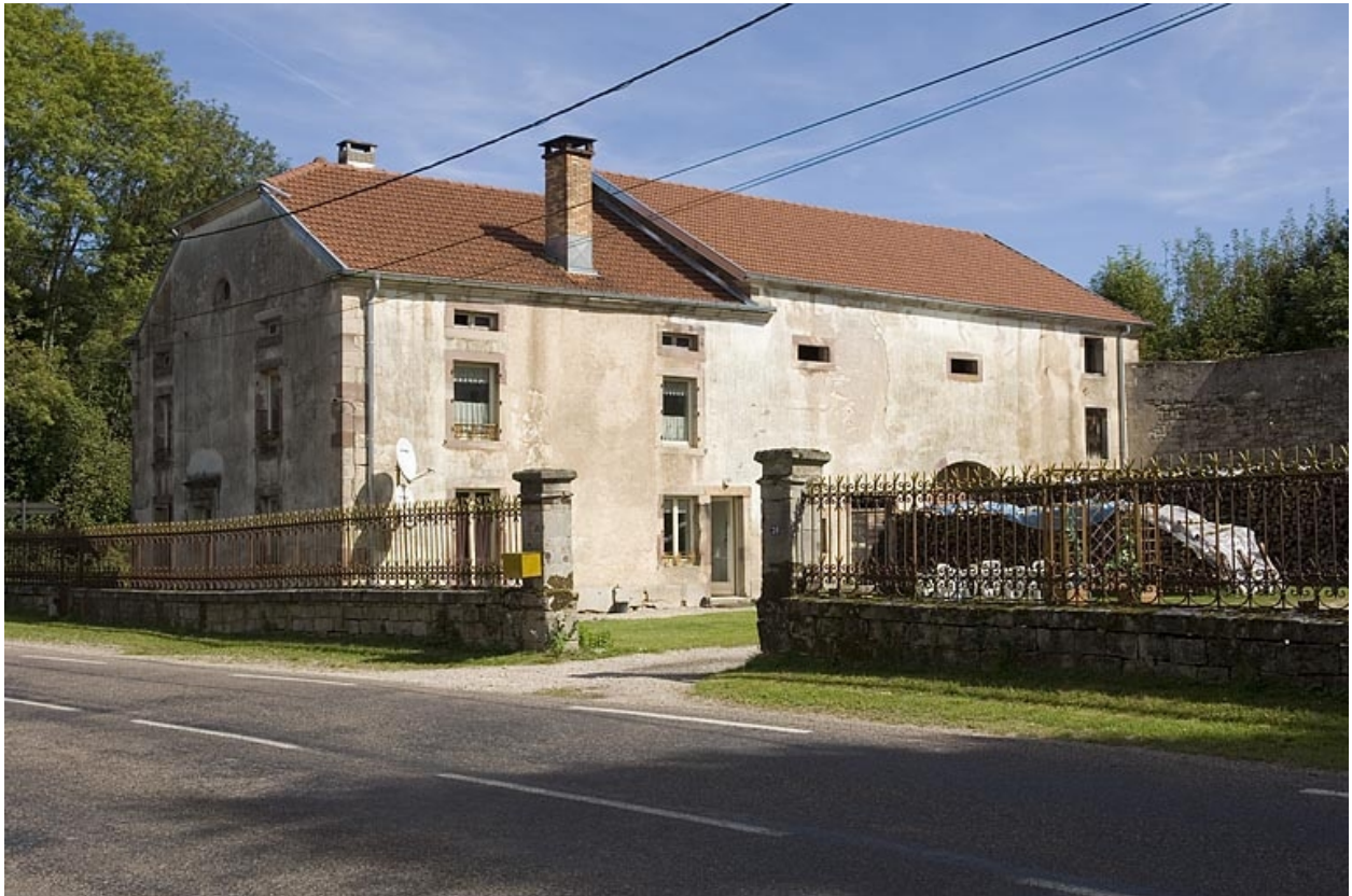
Logement patronal et parties agricoles.
