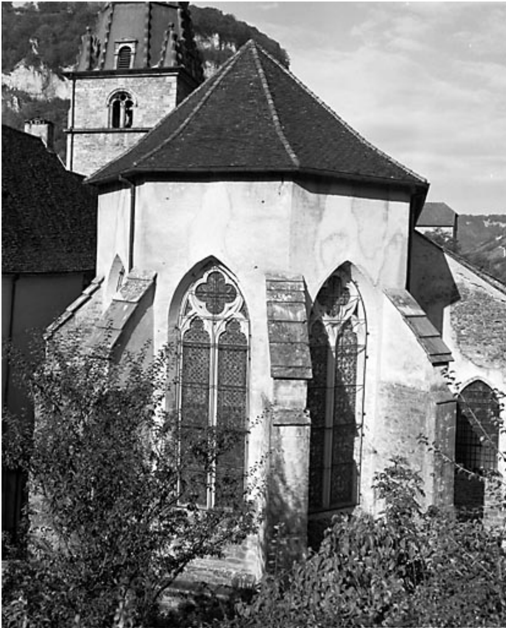
Eglise abbatiale, vue extérieure de l'abside.
