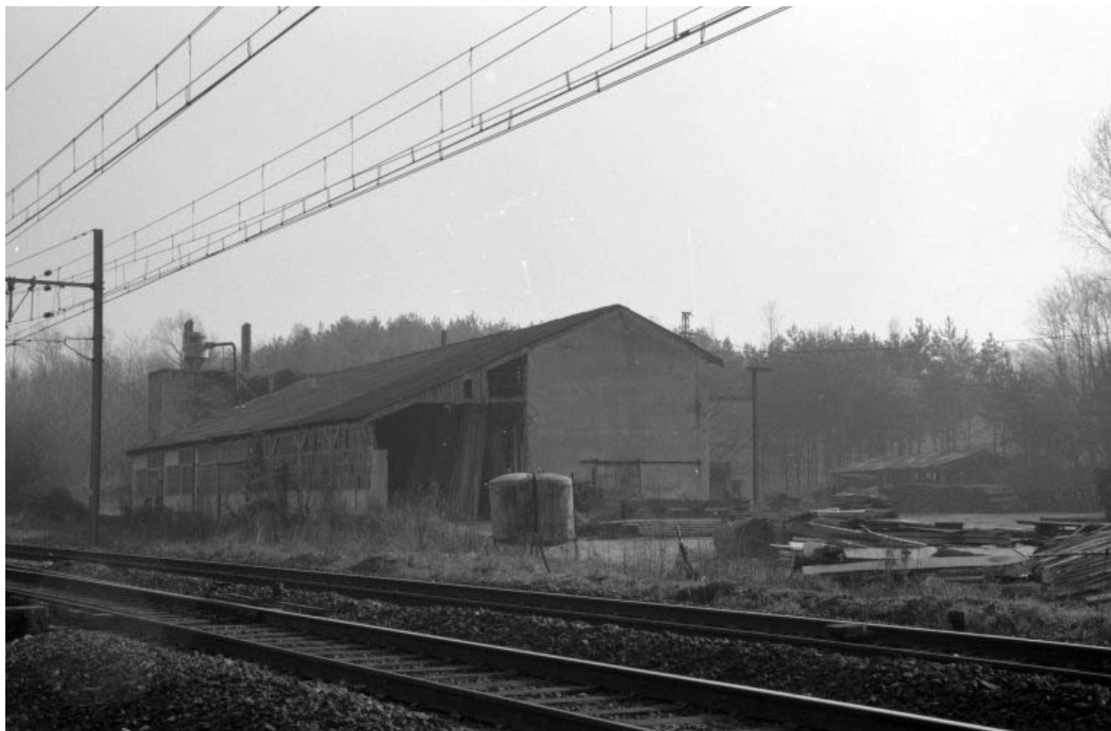
Menuiserie (M), depuis le nord-est.
