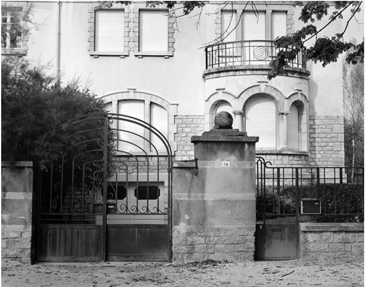
Détail : portails d'entrée dans la cour du 14 avenue Albert 1er.
