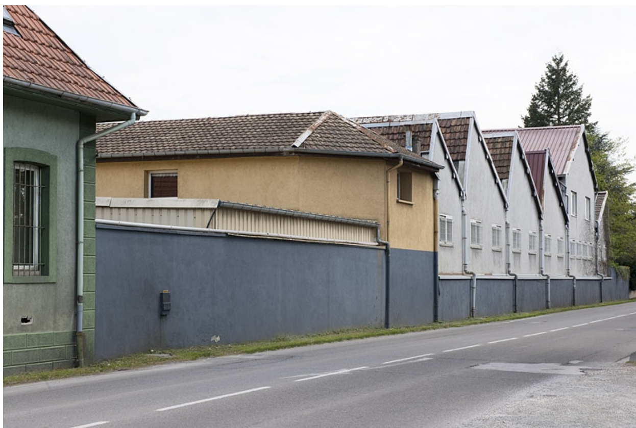
Façade sur rue de l'atelier de fabrication.
