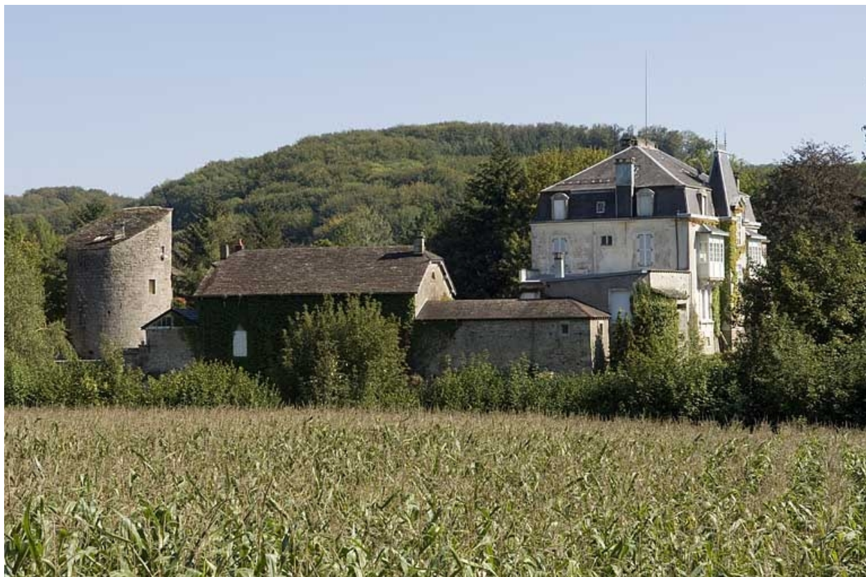
Logement patronal depuis le nord-ouest.
