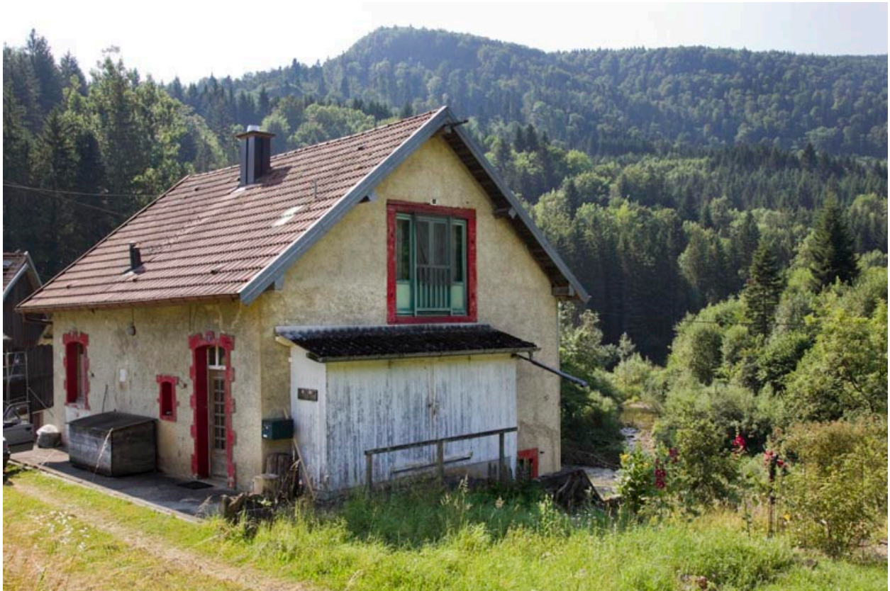
Logement d'ouvriers, de trois quarts droite.
