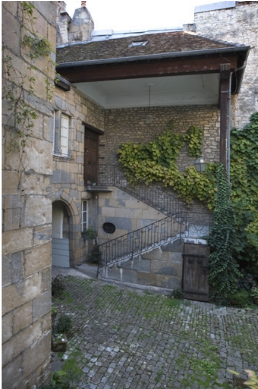
Vue d'ensemble de l'escalier extérieur, de face.
