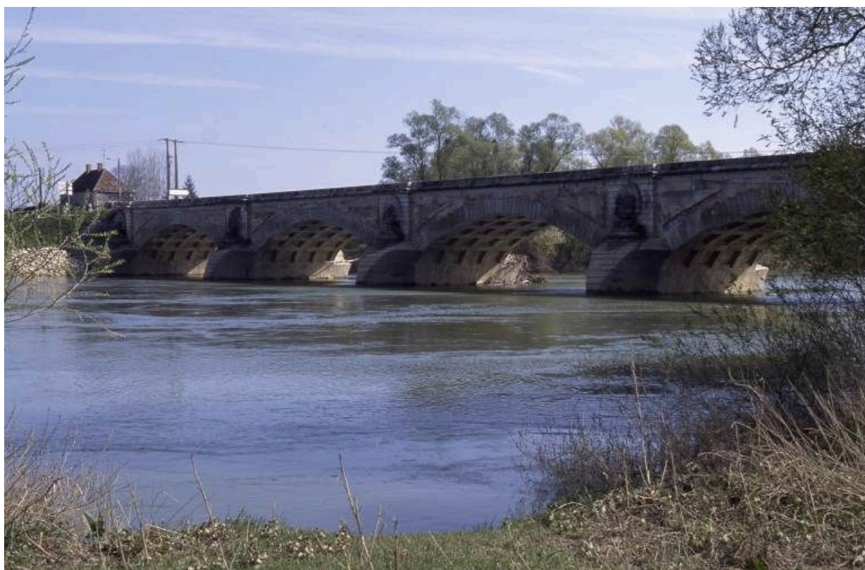
Vue d'ensemble de trois-quarts droit, en aval.
