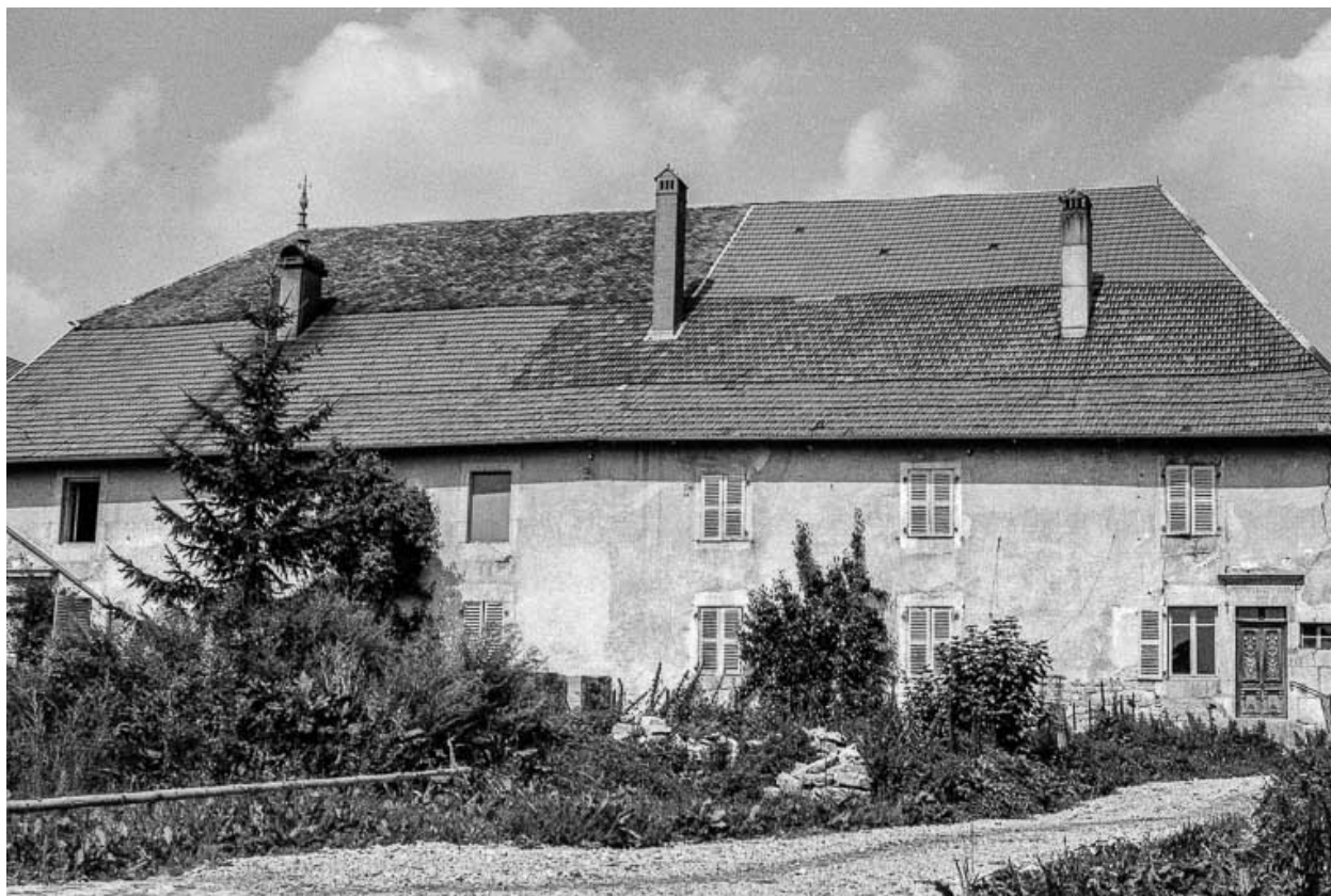
Ferme cadastrée 1972 ZM 63a-64a : façade antérieure.
