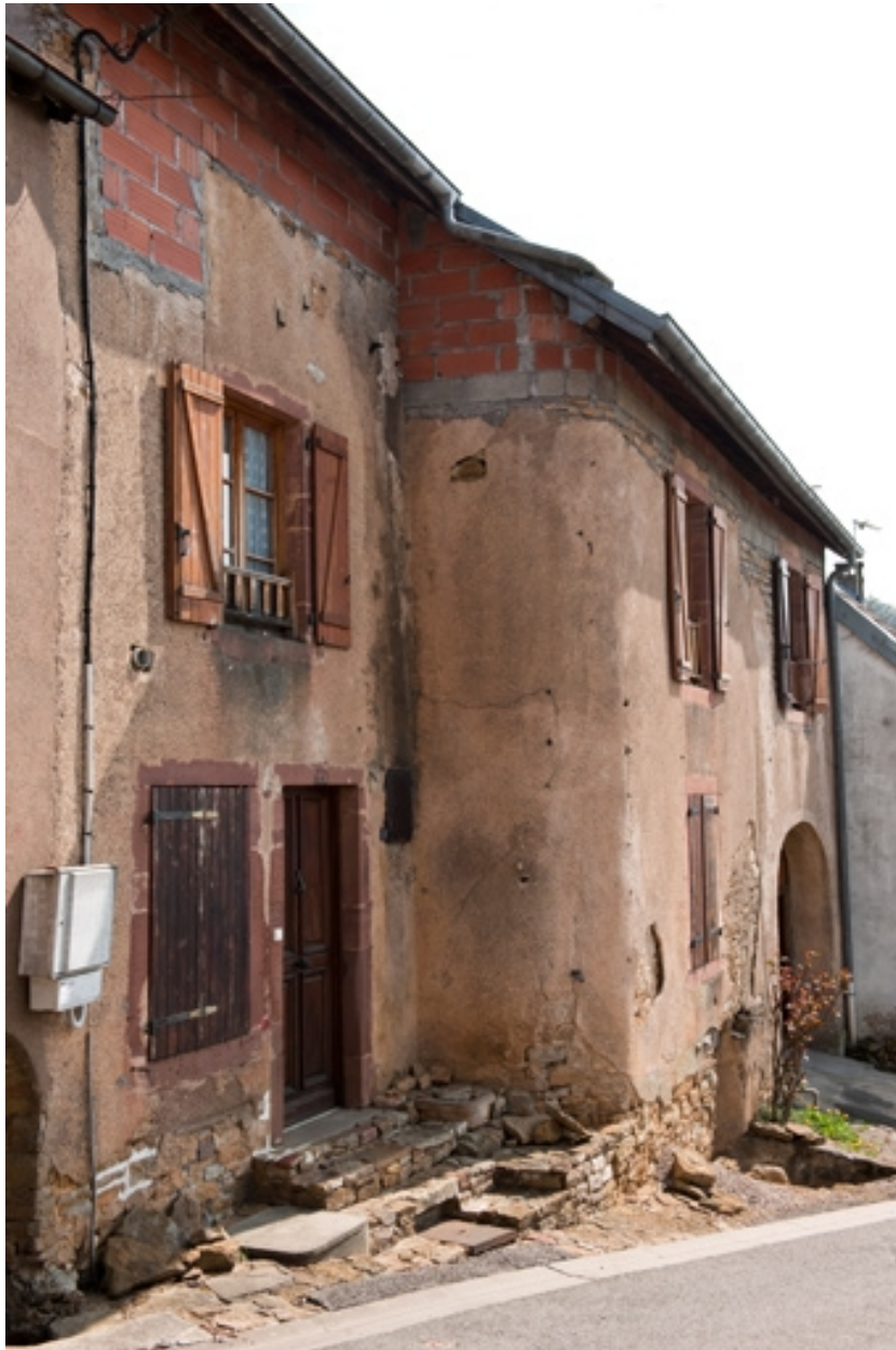
Façade antérieure, vue de trois quart gauche.
