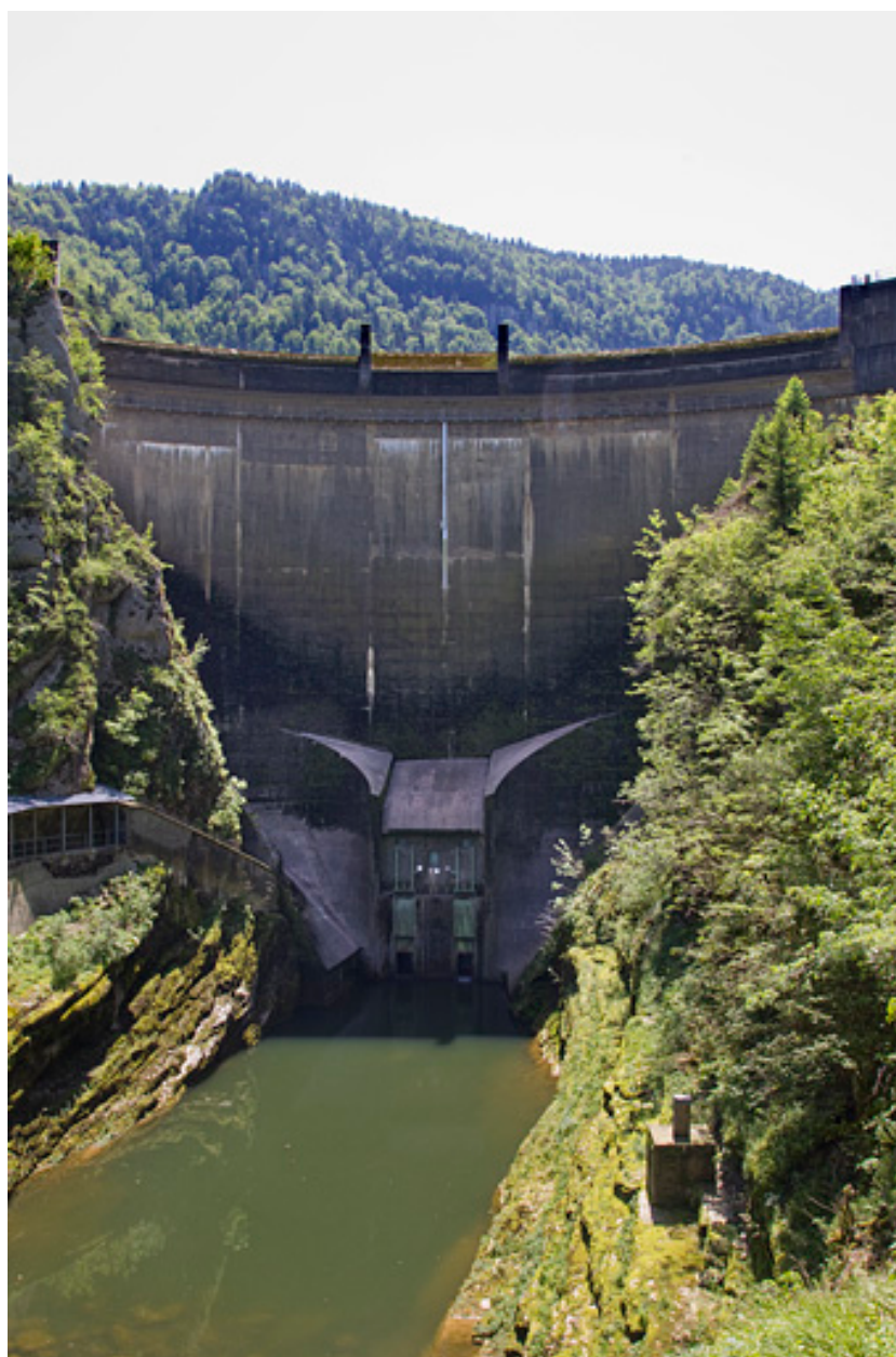
Barrage du Châtelot : face aval.
