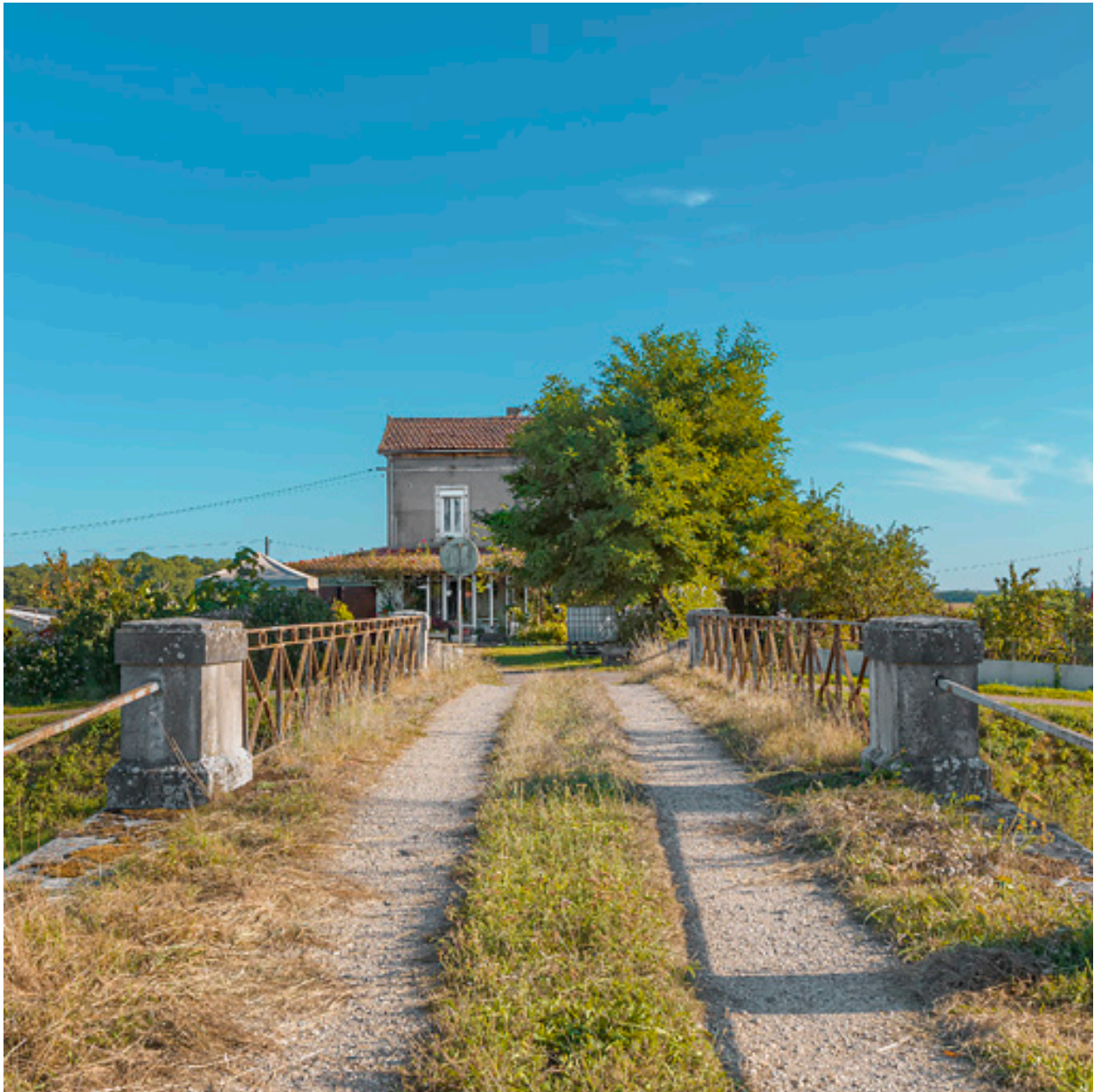
Vue d'ensemble du pont sur l'écluse depuis la rive droite. En face, la maison éclusière.
